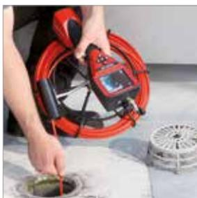
Ispezione di tubi a pavimento
