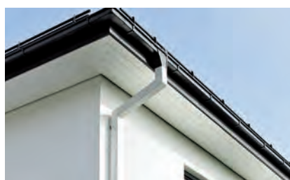
Esempio fissaggio pluviale sezione quadra
