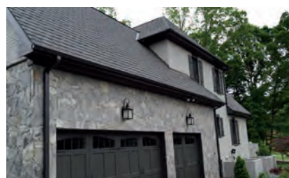
Esempio fissaggio pluviale sezione 100x70
