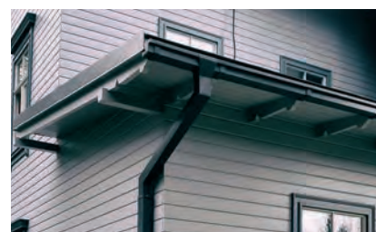
Esempio fissaggio pluviale sezione tonda
