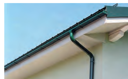
Esempio fissaggio pluviale sezione tonda
